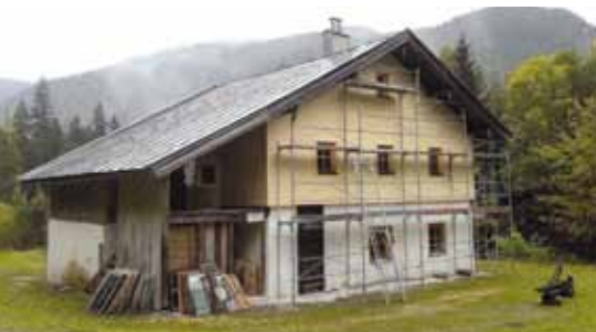
Die Außenfassade wird renoviert
